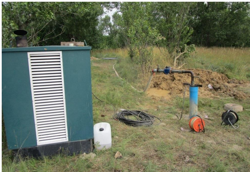
Spurgo del pozzo con pompa sommersa, contaltri e gruppo elettrogeno
