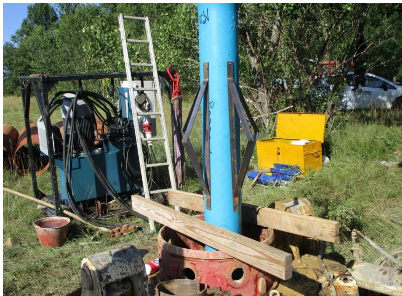
Tubazione definitiva con centralizzatori
