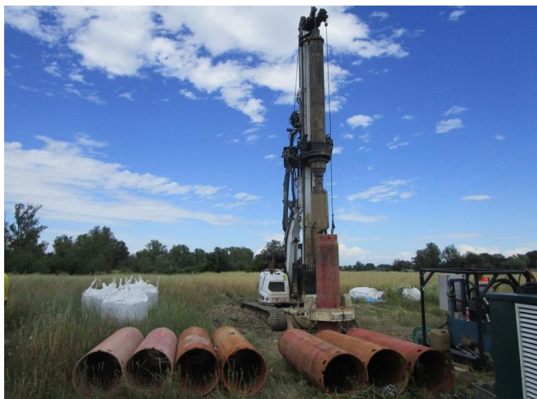
Attrezzatura per pozzi con i tubi di rivestimento provvisorio da 600 mm
